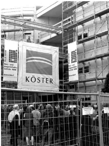
Richtfest am 27. September
